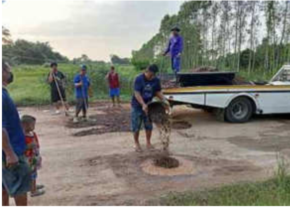
สนับสนุนดินลูกรังซ่อมแซมถนนบริเวณถนนข้ามทางรถไฟ หมู่ที่ ๑๑ บ้านหนองเสม็ด
