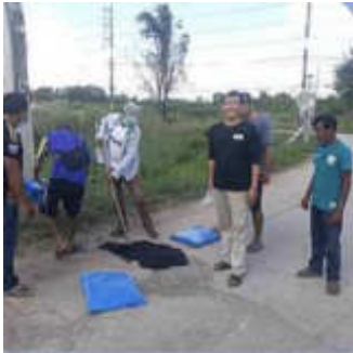
ซ่อมแซมผิวจราจรด้วยวัสดุยาง มะตอย หมู่ที่ ๘ บ้านลัดกระสัง
