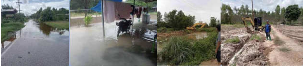
นำรถแบล็คโครมาขุดเปิดทางน้ำให้กับประชาชน หมู่ที่ ๓ บ้านใหม่คำเจริญ และหมู่ที่ ๑๑ บ้านหนองเสม็ด ที่ได้รับความเดือดร้อนจากน้ำท่วม
