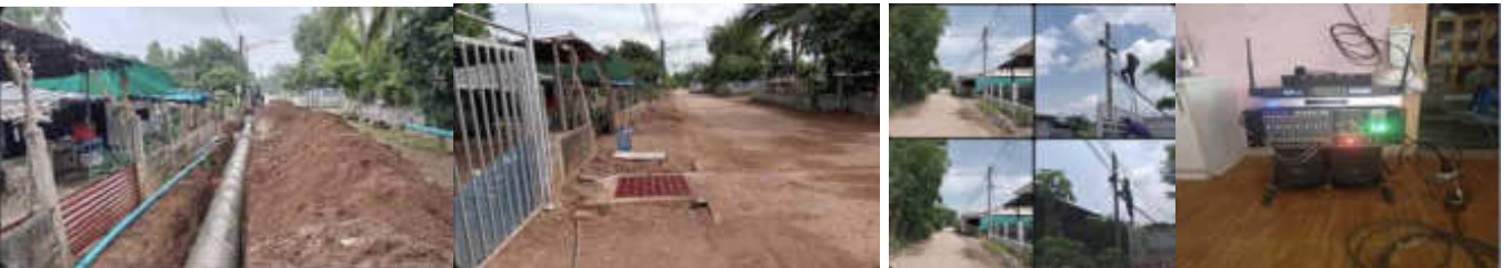
โครงการฝังท่อระบายพร้อมบ่อพัก หมู่ที่ ๑๐ บ้านสี่แยก บริเวณศาลากลาง หมู่บ้านถึงบริเวณหน้าบ้านนางลภัส ทูคำมี
