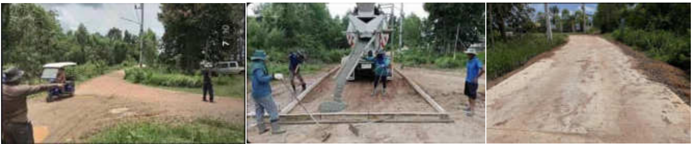
โครงการก่อสร้างถนนคอนกรีตเสริมเหล็ก หมู่ที่ ๔ บ้านคลองหมี่ ซอยข้างประปาหมู่บ้านถึงอินทผาลัม
