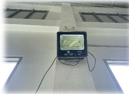
ภาพแสดงการใช้ Solar cell ที่สถานีแรงต่ำคลองพระสะทึง
