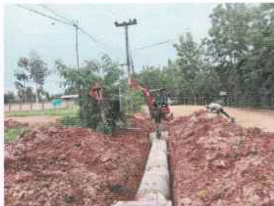
๑๕.โครงการฝังท่อระบายน้ำ คสล.บริเวณหน้าที่ทำการ อบต.แห่งใหม่หมู่ที่ ๑๘ บ้านเนินกลาง
